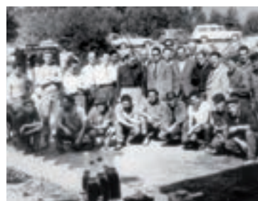
1962 Les travaux sur les captages de Pré-Grivel à Vizille.
