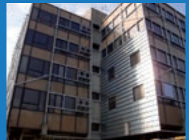
2009/2010. Le Verseau. Avant et après les travaux de réhabilitation.
