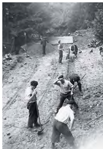
Les séminaristes travaillent aux fondations du chalet durant l'été 1951.
