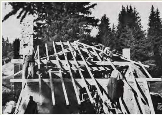
Les séminaristes posent la charpente de la chapelle, au début de l'automne.
