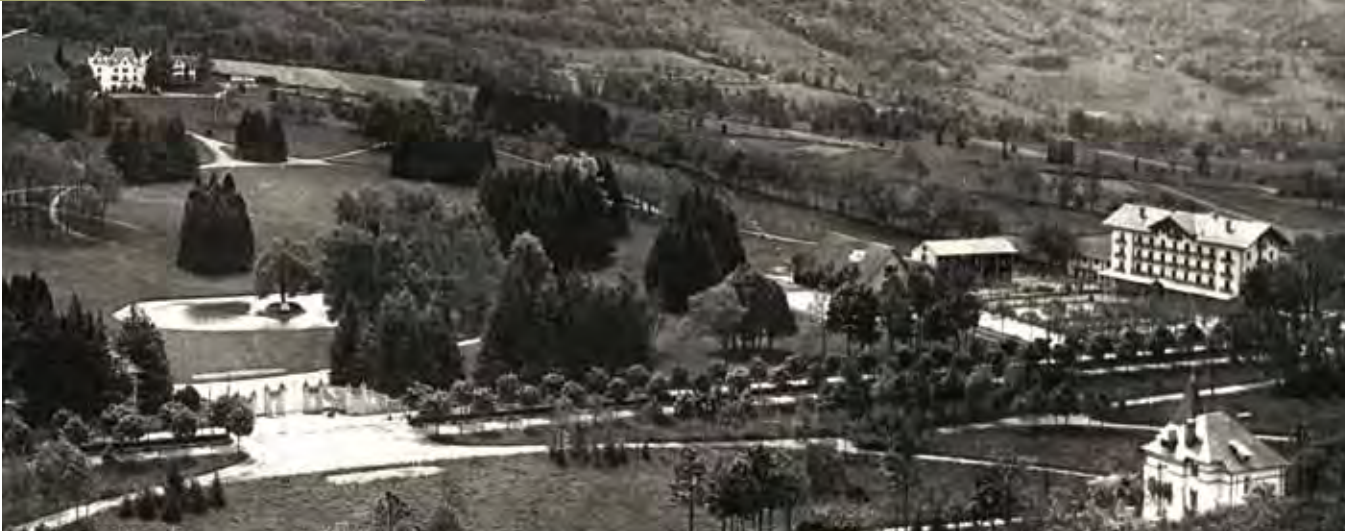
Vue d'ensemble du parc des Alberges. En haut sur la gauche, le château. En dessous le petit lac aujourd'hui disparu et l'imposant portail en fer forgé de l'entrée principale. A droite l'hôtel construit en 1909 et au premier plan quelques maisons bâties par Stéphane Jay.
