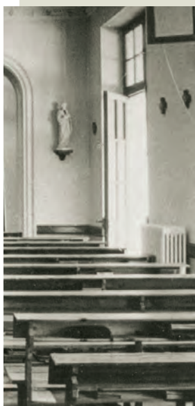
La salle de restaurant de l'hôtel des Alberges transformée en chapelle.
