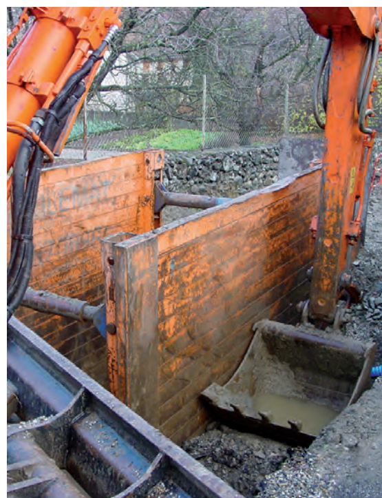
Les travaux Chemin des Ogiers
