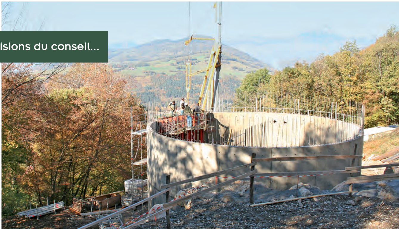
Le chantier en pleine activité
