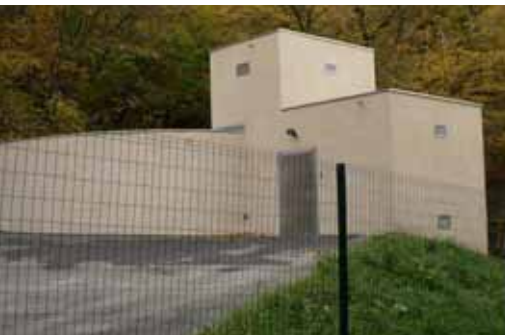
Le réservoir du Replat rénové
