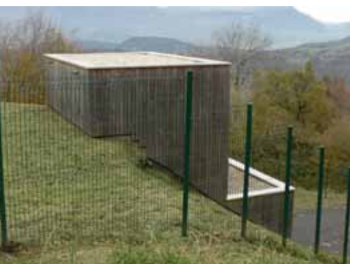
Le réservoir du Roul
