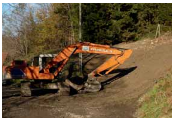
Le réservoir de Chaloin en fin de démolition
