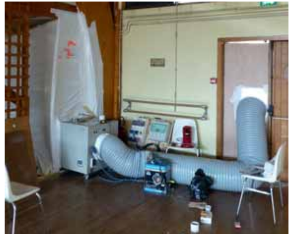
Le «désamiantage» dans la salle des fêtes par la Société RUDO CHANTIER, de Norges-la-Ville (21490) pour enlever le carrelage des anciennes toilettes dont la colle contenait de l'amiante.
