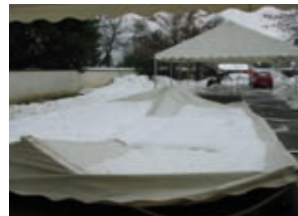
Chapiteaux effondrés pour le marché de Noël
